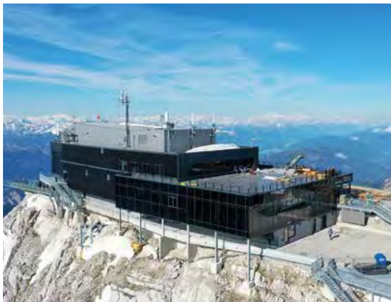
Ost-, West- und Südseite sind mit Photovoltaik-Paneelen verkleidet, welche rund 100.000 kWh pro Jahr produzieren. Das sind etwa 80 Prozent der benötigten Energie für die Bergstation.
